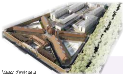
Maison d'arrêt de la Santé (Paris) : vue aérienne - APIJ
