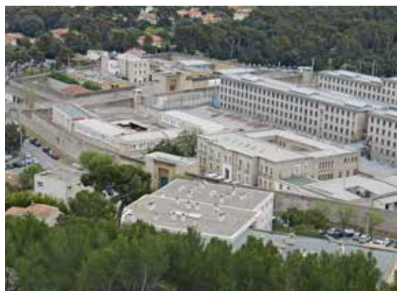
Le GRETAP de Marseille, situé au sein du centre pénitentiaire de Marseille (Bouches-du-Rhône), photographie prise en 2016
