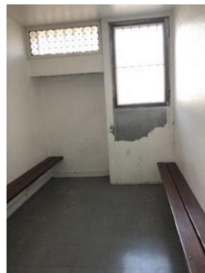
Une cabine de parloir du bâtiment A
