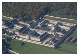
Vue aérienne de la maison centrale de Clairvaux (Coll. ÉNAP-CRHCP)
