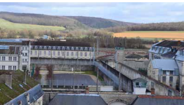
Clairvaux, vue d'ensemble - Énap
