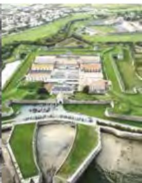
Maison centrale de Saint-Martin-de-Ré (Coll. CRHCP)
