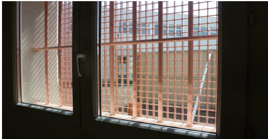
« Fenêtres équipées de caillebotis (vue de l'intérieur) », EPM de Lavour en 2015 247
