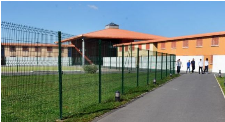
Sécurisation des espaces de circulation, EPM de Lavour en 2015 245
