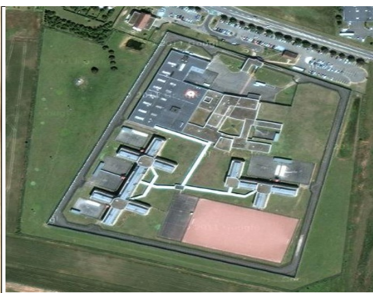
Illustration 5: Centre de détention de Châteaudun
